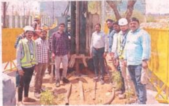
ఎయిర్పోర్టు మెట్రో పిల్లర్ల నిర్మాణం కోసం భూసామర్థ్య పరీక్షలు నిర్వహిస్తున్న దృశ్యం
