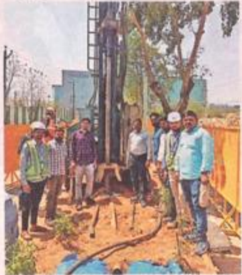
రాయదుర్గం ఐకియా ఎదురుగా ప్రధాన రహదారిపై ఎయిర్పోర్టు మెట్రో కోసం భూసార పరీక్షలను ప్రారంభించిన మెట్రో అధికారులు
