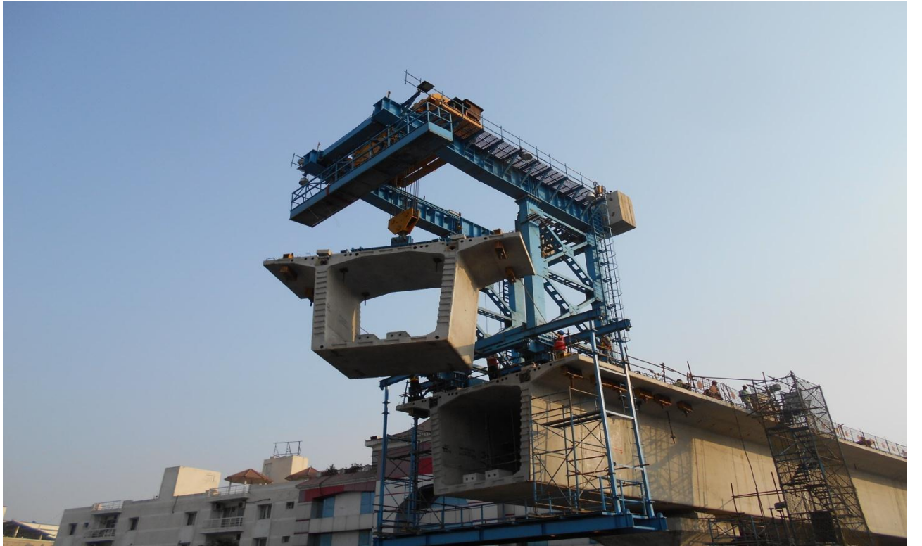
బ్రిడ్జ్ బిల్డర్ ను ఉపయోగించి నిర్మించిన బేగంపేట్ మెట్రో ఆర్వోబీ నిర్మాణ క్రమంలో సెగ్మెంట్ అనుసంధాన ప్రక్రియ
