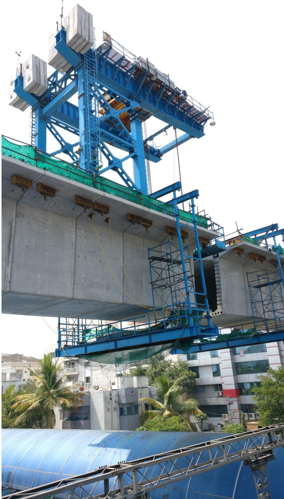
బ్రిడ్జ్ బిల్డర్ ను ఉపయోగించి నిర్మించిన బేగంపేట్ మెట్రో ఆర్చ్ బీ
