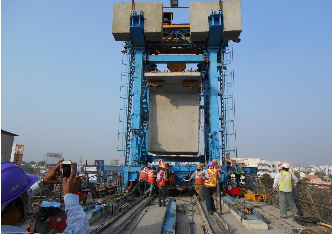
బిడ్డ బిల్డర్ ను ఉపయోగించి నిర్మించిన బేగంపేట్ మెట్రో ఆర్వోబీ నిర్మాణ క్రమంలో లిఫ్టింగ్ & లాచింగ్ ప్రక్రియ
