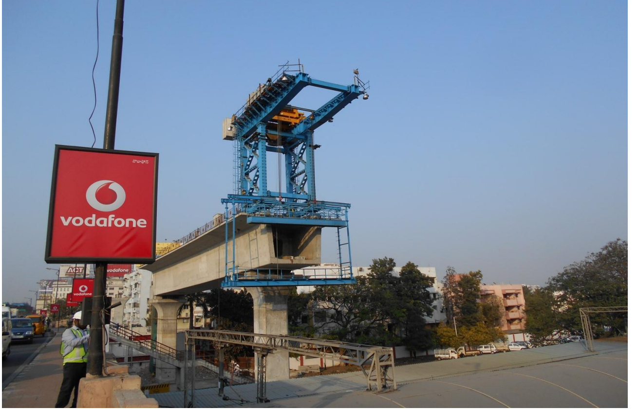
బ్రిడ్జ్ బిల్డర్ ను ఉపయోగించి నిర్మించిన బేగంపేట్ మెట్రో ఆర్వోబీ నిర్మాణ క్రమంలో యాంకరింగ్ ప్రక్రియ
