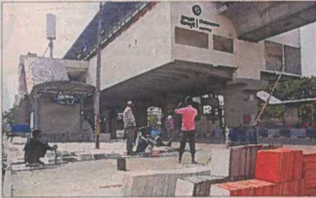
వైతన్యపురి స్టేషన్ వద్ద కొనసాగుతున్న ఫుట్ పాత్ పనులు
