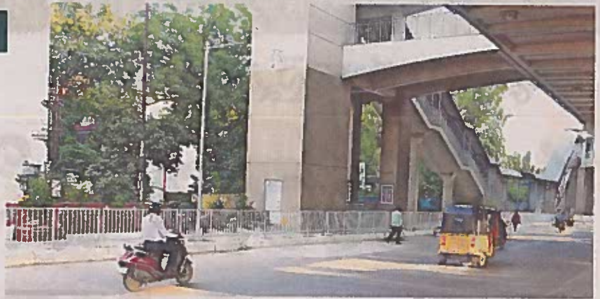
పంజీవరెడ్డివగర్ మెట్రో స్టేషన్ మెట్ల మార్గం నుంచి బస్టాపు వరకు ఏర్పాటు చేసిన ఇనుప గ్రైల్స్
