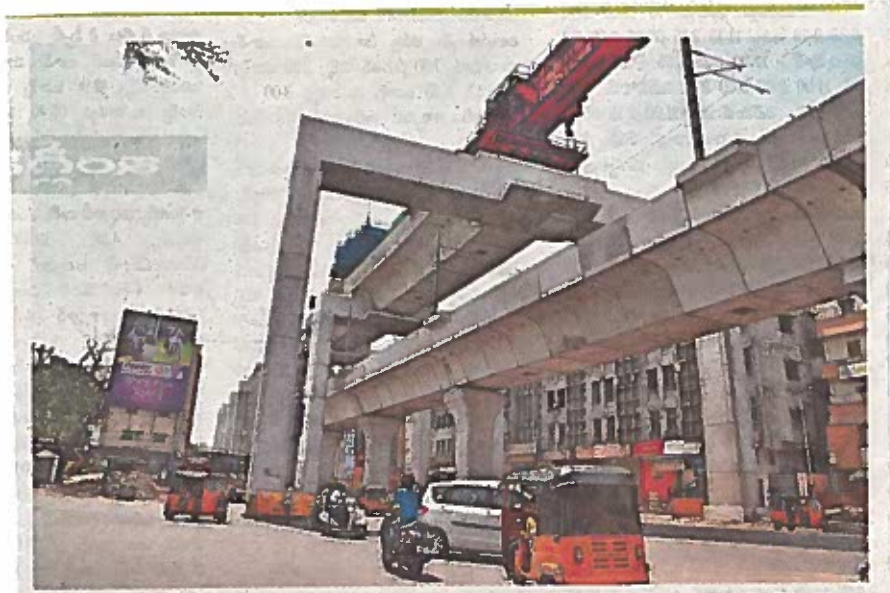
దమిల్ డెక్ ఆక్టివ్ అకట్టుకుంటున్న మెట్రో నిర్మాణమిది. వైమన్ల ట్రాక్ ఎంజీజీఎస్-జేజీఎస్ మార్గంలోనిది. చివరి వ్తంభం పని జరుగుతోంది. ఇవి పూర్తయితే కిందనున్న మియాపూర్-ఎల్బీ నగర్ ట్రాక్ కు విద్యుదీకరణ పూర్తి చేసి ఫ్రయల్ రన్ ప్రారంభించవచ్చు. పుత్తిబారి-రంగమచాల్ చౌరస్తా వద్ద తీసిన చిత్రమిది.
