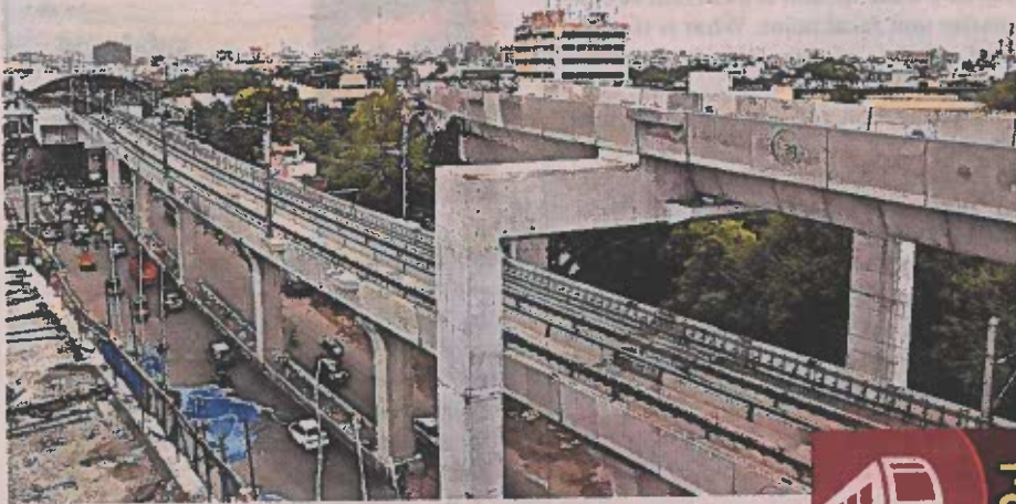
రంగమహల్ చౌరస్తాలో ఒక మెట్రో కారిడార్‌పై మరో మెట్రో కారిడార్ నిర్మాణం
