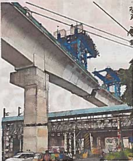
మలకేపేట రైల్వే లైనుపై నిర్మించిన మెట్రో ఆర్కేపీ
