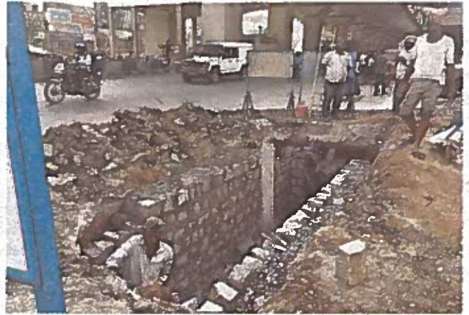
కేపీహెచ్ఐసీ కాలనీ మెట్రో స్టేషన్ వద్ద లోతట్టు ప్రాంతంలో నిర్మిస్తున్న ఇంజక్షన్ బోర్ వెల్ ఇంకుడు గుంత
