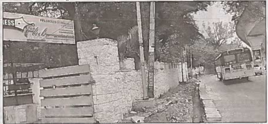
మెట్రో ఎదుట పుట్పాతల నిర్మాణం కోసం జరుగుతున్న పనులు
