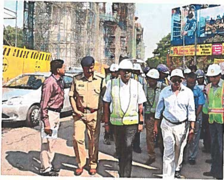
పనుల పరిశీలనలో మెట్రో ఎండ్ ఎస్వీఎస్ రెడ్డి, అధికారులు
